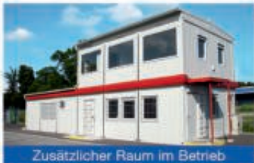
Zusätzlicher Raum im Betrieb
